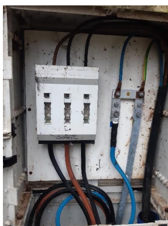
Rysunek 3. Złącze, które należy przebudować lub wymienić, do którego ma zostać wpięta mikroinstalacja fotowoltaiczna
