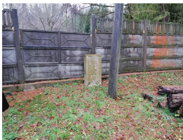
Rysunek 3. Złącze, które należy przebudować lub wymienić, do którego ma zostać wpięta mikroinstalacja fotowoltaiczna
